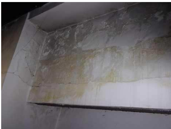
Vlhkost v kotelně v 1.PP po zatékání z rampy
