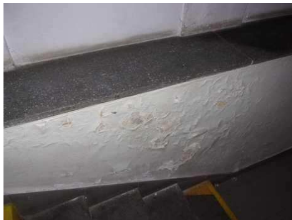
Stopy po vlhkosti na schodišti do 1.PP
